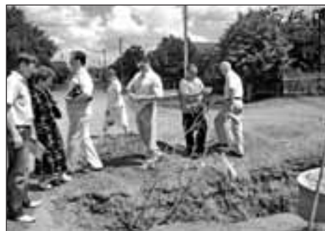
Будівництво водогону у с. Олексіївка Софійського району (Дніпропетровщина)
