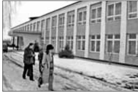
Відреконструйована ЗОШ I-III ступенів с.Мощаниця
